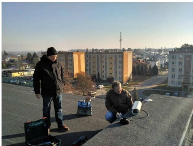
Zdj. 1. Montaż stacji, od lewej Mirosław Mazur i Zbigniew Tymiński, fot. Artur Jaśkiewicz
